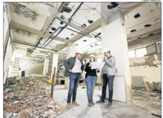
El maig passat van començar les demolicions a l'antiga Audiència.
